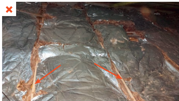
Les panneaux d'isolant, posés en une seule épaisseur, ne recouvrent pas la structure porteuse en bois. ©AQC
