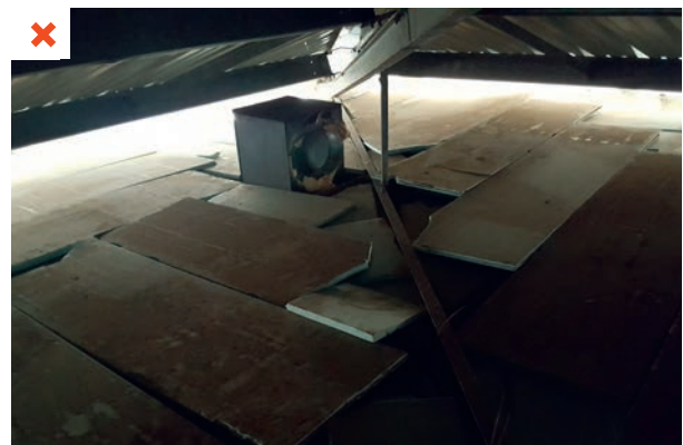
Panneaux de polystyrène non jointifs. Absence de calepinage et de découpes soignées. ©AQC
