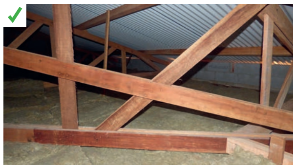
La couche d'isolant recouvre les éléments de la structure porteuse du plafond, ce qui limite ainsi les ponts thermiques. ©AQC
