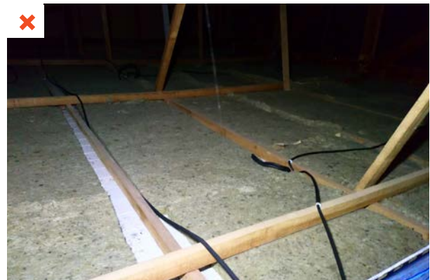
Les panneaux d'isolant ne sont pas jointifs. L'isolation n'est pas continue. ©AQC
