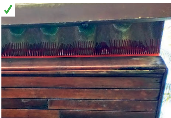
Peigne de protection antinuissibles (attention : les peignes sont très efficaces contre les chauves-souris, mais peuvent être détériorés par les rongeurs). Il est nécessaire d'adapter les matériaux à la configuration et aux types de nuisibles. ©AQC
