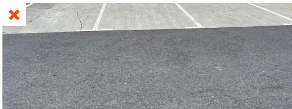
Places de parking minéralisées. ©AQC
