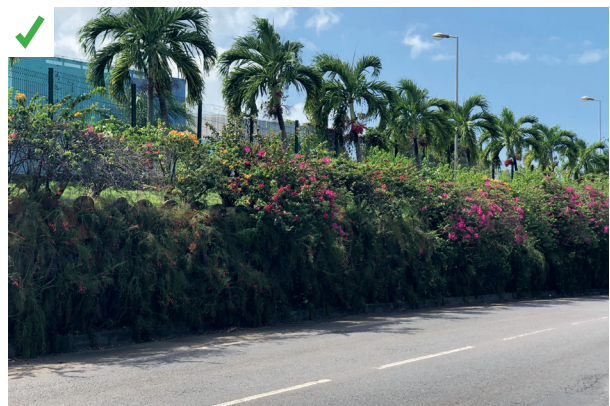
Talus végétalisé. Différentes essences à enracinement profond sont choisies. Les palmiers sont implantés en retrait du talus.
