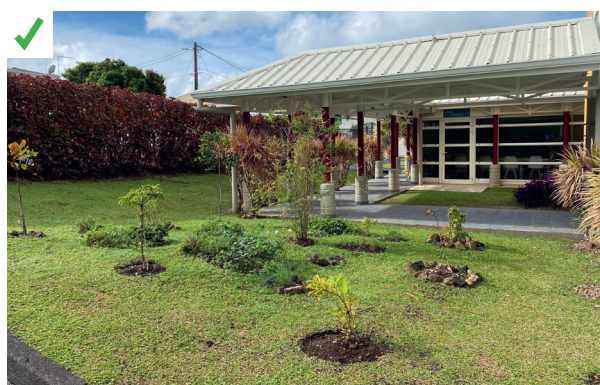
Sol végétalisé aux abords d'un bâtiment permettant une infiltration directe des eaux de pluie. ©AQC
