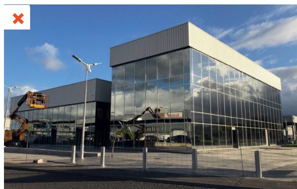
Façade non végétalisée et sans protection solaire. ©AQC
