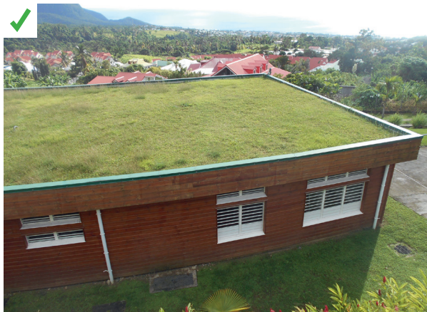
La toiture végétalisée fait partie de la stratégie globale de protection solaire et de rafraîchissement. ©Equinox
