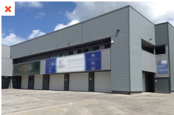
Revêtement du sol à la périphérie du bâtiment non protégé du rayonnement solaire et sans aucune recherche d'implantation de végétaux. ©AQC
