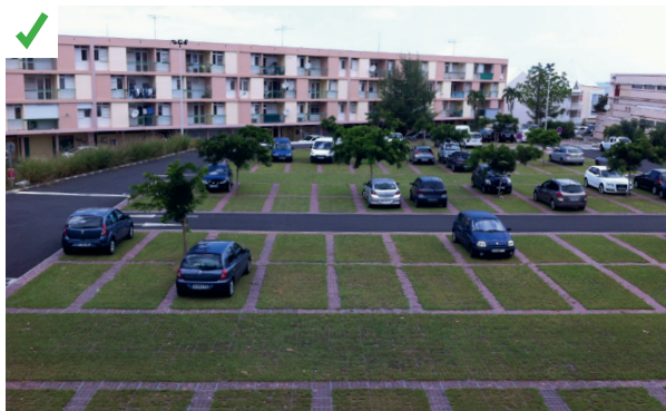
Places de parking végétalisées avec des dalles perméables.
