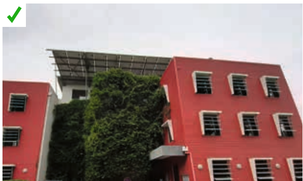
Dans cet immeuble de bureaux, les concepteurs ont su combiner plusieurs types de protections solaires pour protéger chaque façade efficacement. Sur cette vue, les menuiseries de la façade ouest sont protégées par des casquettes et joues doublées de brise-soleil. Une partie de cette façade ouest est également protégée par une double-peau végétale. Au nord, les menuiseries sont protégées par une casquette et une joue sur le côté ouest. ©AQC
