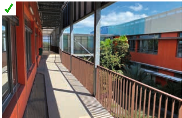
La couverture de cette coursive protège efficacement la façade, grâce à une retombée métallique sous forme de bandeau périphérique. ©AQC
