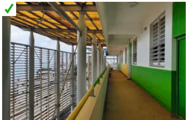
L'architecte a profité de la restructuration du bâtiment pour ajouter d'importants dispositifs protégeant les coursives et la façade : couverture en polycarbonate coloré limitant les rayonnements solaires et grands panneaux verticaux composés de lames brise-soleil fixes horizontales. ©AQC
