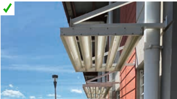
Fixation de la casquette assurant une reprise complète des forces.
