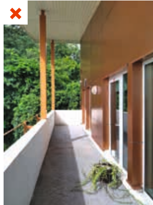
Le 2 e étage de cet immeuble de bureaux est entouré d'une coursive couverte par un débord de toiture. Le positionnement trop élevé de la couverture ne permet pas de protéger du soleil les baies vitrées et la paroi. ©AQC
