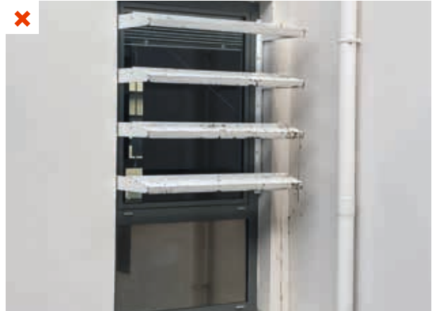
Les protections solaires sont directement fixées sur le cadre de la menuiserie et risquent de s'arracher en cas de vents forts.
