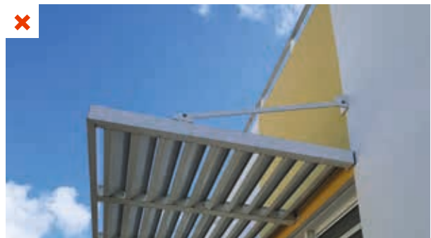
Les casquettes ajourées forment un brise-soleil fixé uniquement par le haut et en traction. Si les casquettes venaient à se soulever sous l'effet d'une secousse sismique ou d'un vent cyclonique, l'ensemble pourrait tomber et blesser des personnes.
