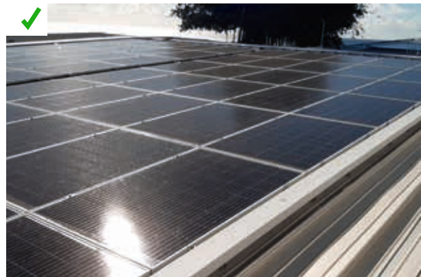
Production PV alimentant directement un Groupe d'Eau Glacée au travers d'un automate de gestion. Le surplus d'électricité produit est réinjecté sur le réseau. ©AQC
