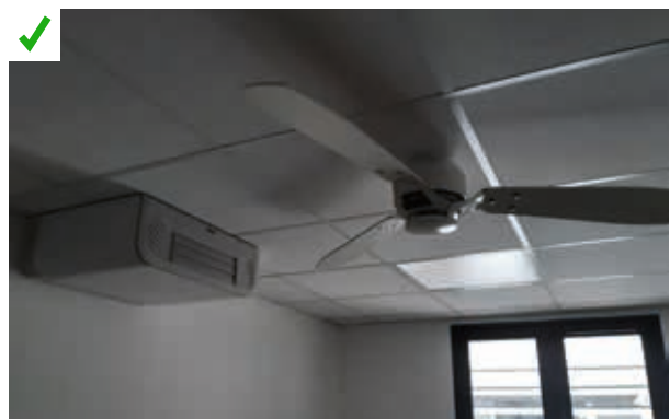
Bureau équipé d'un brasseur d'air permettant d'augmenter la consigne de la climatisation, voire de s'en passer. ©AQC
