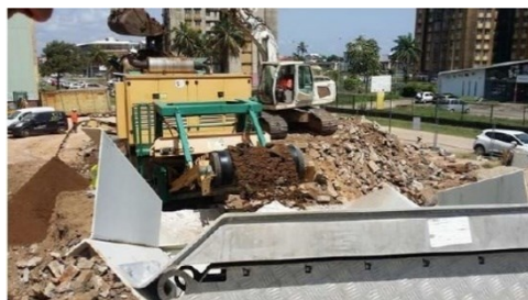
Chantier cité Médan, 2015, photo Eiffage TP
