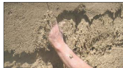
Pose de l'enduit, © Tom Rijven
