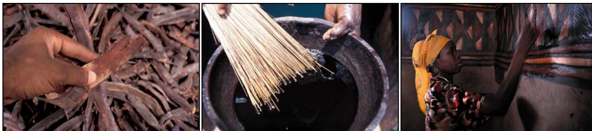
Cosses de néré ; décoction ; application du vernis protecteur © Gisèle Taxil/CRAterre-ENSAG
