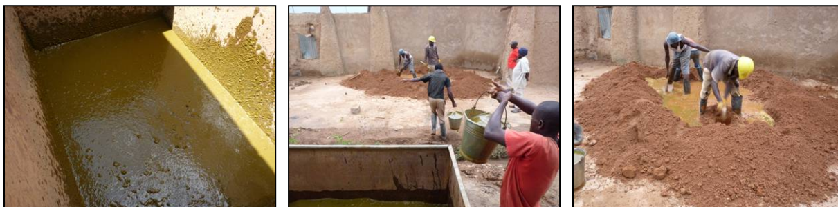
Préparation du mélange de vuolu , bouse de vache et terre. © Sébastien Moriset/CRAterre-ENSAG
