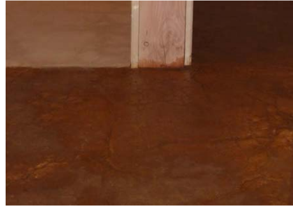
Traitement de surface du sol : mélange de cire d'abeille et de cire de carnauba, brindibule.blogspot.fr/2011/01/dalle-en-terre-couche-de-finition.html
