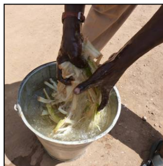
Préparation du vuolu et de la bouse de vache. © Sébastien Moriset/CRAtterre-ENSAG
