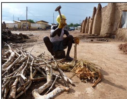
Préparation du vuolu et de la bouse de vache. © Sébastien Moriset/CRAtterre-ENSAG
