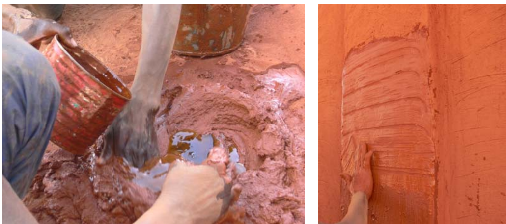
Préparation d'un enduit à base de terre rouge et de beurre de karité fondu, Ségou, Mali © Laetitia Fontaine/CRAterre-ENSAG
