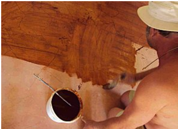
Dernière couche sur un sol en terre : mélange de cire d'abeille, essence de térébenthine, huile de lin, savon noir et pigments, http://rouletabosse.over-blog.fr/article-un-sol-en-terre-crue-57613966.html
