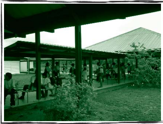
Coursive extérieure couverte pour une meilleure circulation des élèves entre les bâtiments, à l'abri de la pluie et du soleil. (Collège Mana - architecte : Ponthus)
